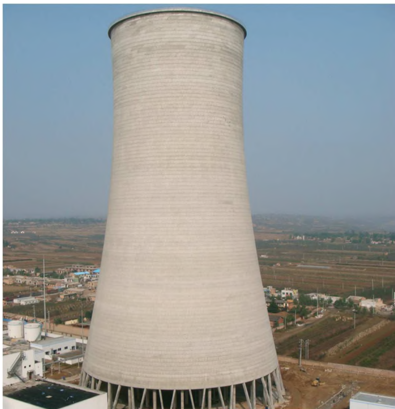
Рисунок 2.30 — Пример воздушной градирни с естественной тягой на угольной электростанции в Китае
