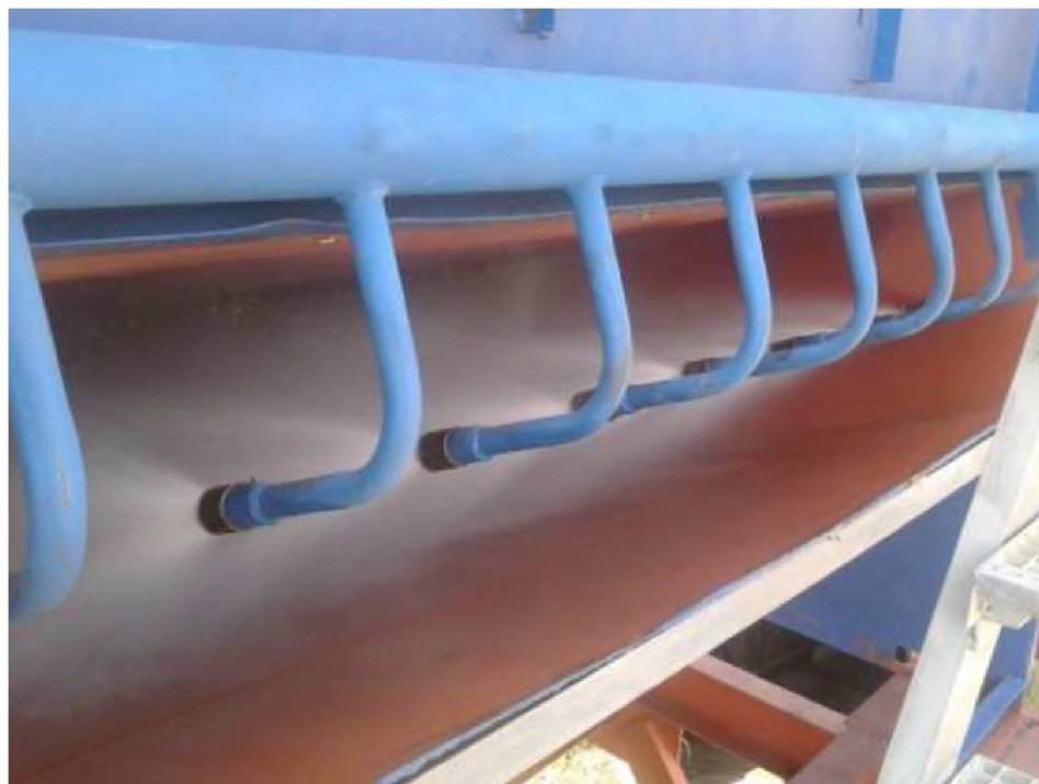
Рисунок 2.15 — Коллектор циркуляционной воды с форсунками эжекционной градирни 3)
